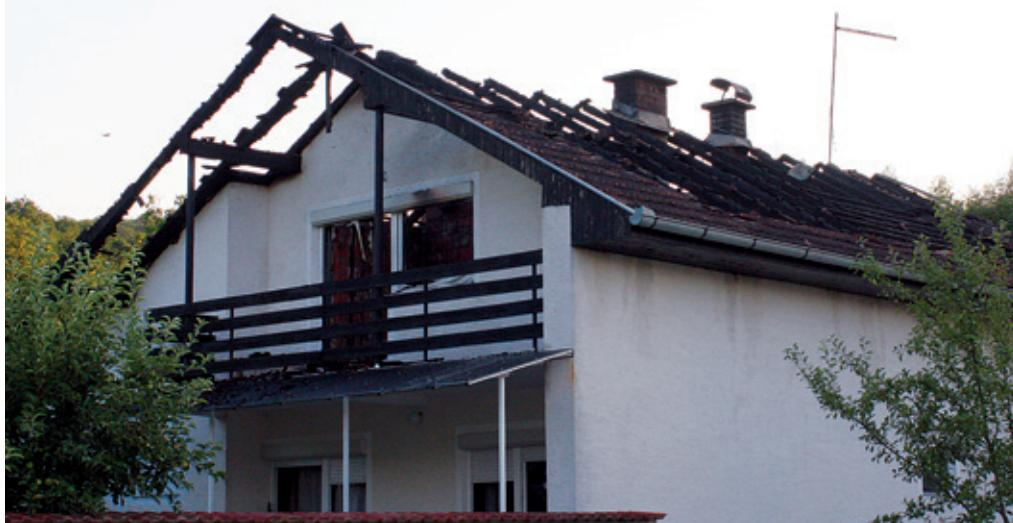
obliku spreja u bočici pod pritiskom koja se nalazila neposredno uz prozor na južnoj strani zida garaže. Bočica je eksplodirala i zapalila gorivi materijal u garaži, nakon čega se požar proširio na kroviste garaže i obiteljske kuće. Šteta nastala ovim požarom procijenjena je na više od sto tisuća kuna!
